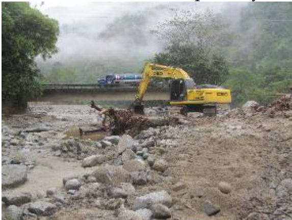
Remoción de material que generó la emergencia
